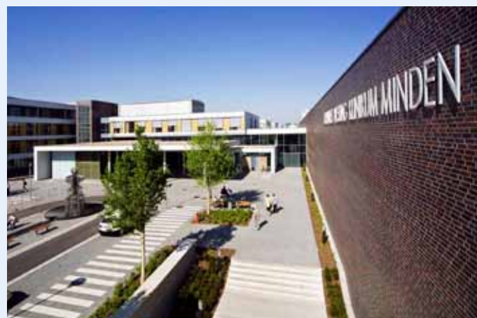
Abb.1: Die Augen-Praxisklinik Minden am neu errichteten Facharztzentrum an der Königstraße. Das moderne Konzept mit großzügigen und lichtdurchfluteten Räumen findet bei Patienten und Mitarbeitern viel Zustimmung. Abb.2: Die Augenklinik Minden ist Fachabteilung am Johannes-Wesling-Krankenhaus, einem der größten und modernsten Klinikneubauten Deutschlands.
