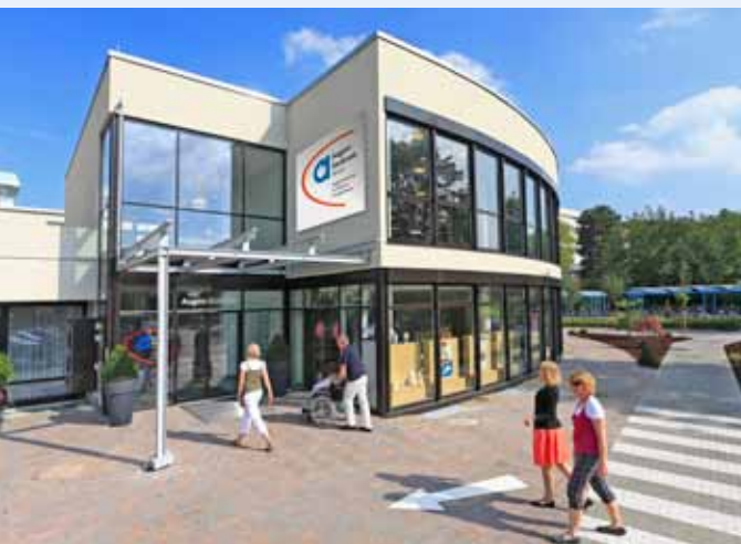
Im Augen-Zentrum-Ahaus wurden an die 2,5 Millionen Euro in moderne Medizintechnik und Ausstattung zum Wohl der Patienten investiert. Das Zentrum wurde nach den Kriterien der Krankenhausbauverordnung erbaut.
